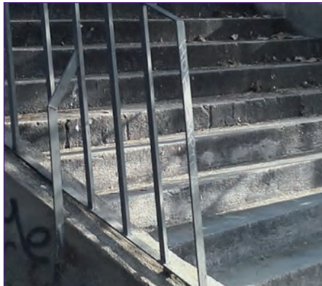
Imagen 34. Ascenso desde la superficie del parque hacia la inseguridad de la carretera.
